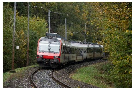
Solothurn West–Oberdorf: Sanierung der Bahnstrecke wird vorbereitet, Züge fahren noch bis am 3. März nach Fahrplan.
